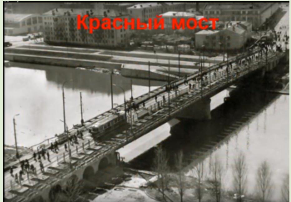
Красный мост в Орле — стальной двухпролётный мост балочной конструкции через Оку в историческом центре города, соединяющий Гостиную улицу на левом берегу Оки с Московской на правом. В основе современного моста — опоры Мариинского моста, построенного в 1877—1879 инженером А. Лебединским, разрушенного при отступлении из города немцами в 1943 году. Восстановлен в 1950 году с заменой несущих пролётов.
